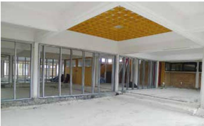
Parallel dazu laufen die Vorbereitungsarbeiten für die Montage der Innenfenster und der Elektrik, für die Herstellung der Beschüttung im Fußbodenaufbau sowie für die Verlegung der Fußbodenheizung und des Estrichs. Die geplanten Fassadenarbeiten werden Mitte April beginnen.
