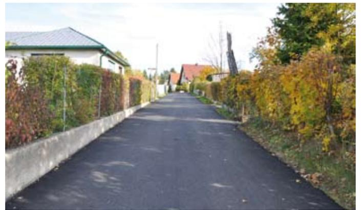
Saniert wurden die Seestraße, ein Großteil der Schaichgasse und die Waldbadstraße im Bereich der Hausnummern 2 bis 6. Die bestehende Fahrbahn wurde hier abgetragen und anschließend neu asphaltiert.
